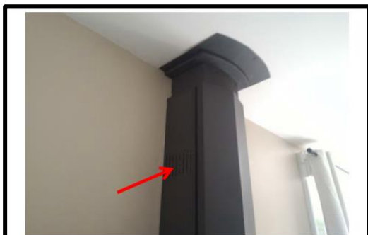
H2: Poêle ou insert non étanche à l'air ou arrivée d'air comburant
