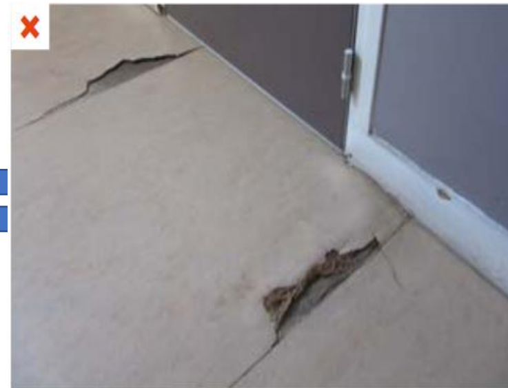
Linoléum qui a cloqué puis s'est percé suite à l'accumulation d'eau en sous-face. ©AQC-2016
