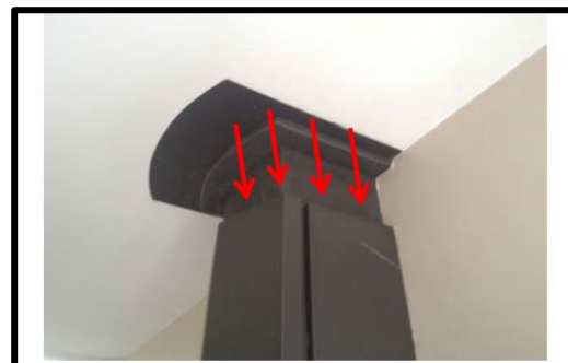
H2: Poêle ou insert non étanche à l'air ou arrivée d'air comburant
